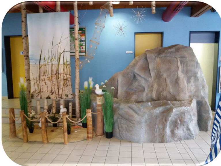
Rückbau Felsbrunnen und maritime Dekoration
