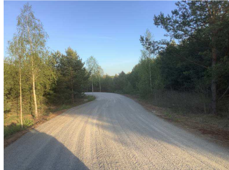
Abb. 29. Zuwegung südöstlich des Plangebietes, Kehre zur Nord-Süd-Strecke.
