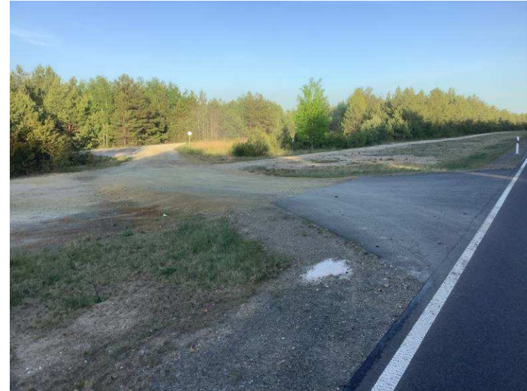
Abb. 33. Zuwegung, Abzweig von der L60.
