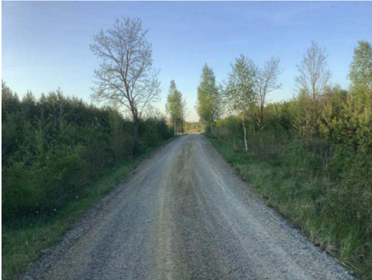
Abb. 27. Zuwegung südöstlich des Plangebietes.
