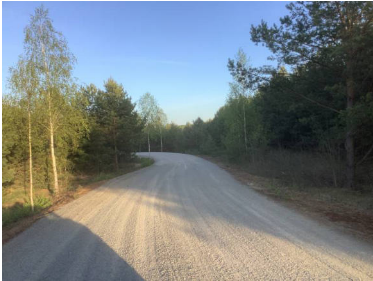
Abb. 38. Zuwegung Referenzfläche Kurve, Westteil.
