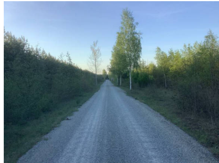
Abb. 41. Zuwegung Referenzfläche Nord, Nordteil.
